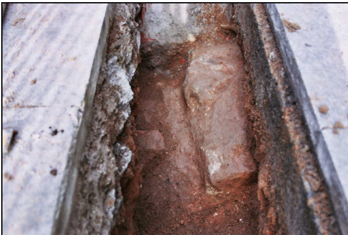
Fotografia 11. Vista del mur corresponent a la U.E. 203, localitzat a la rasa 2.
