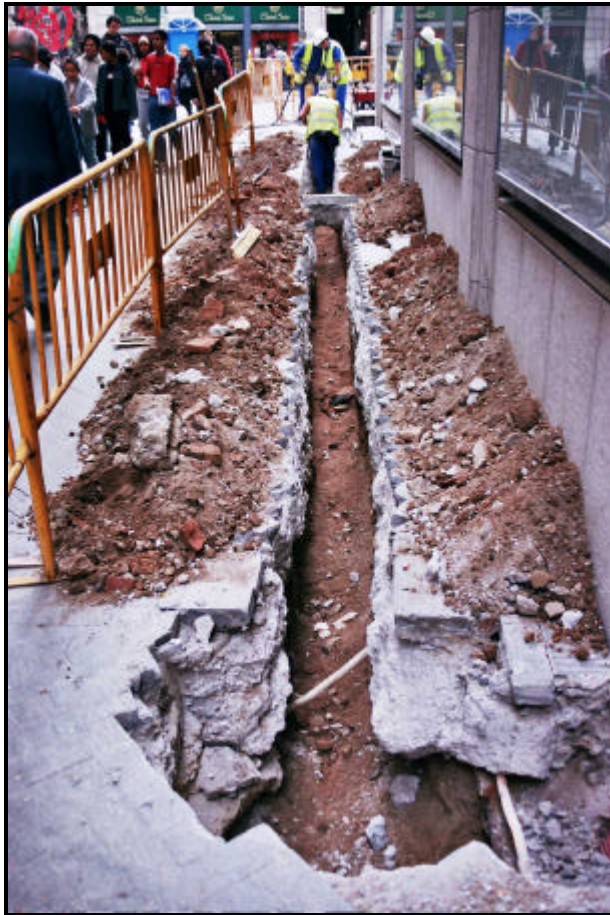
Fotografia 5. Detall rasa 1, un cop realitzat el rebaix a 70 cms.
