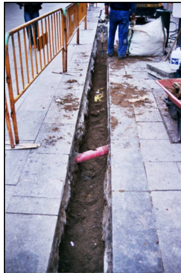
Fotografia 8. Detall rasa 2, realitzat el buidatge de 70 cms. on es localitzava el servei de la llum
