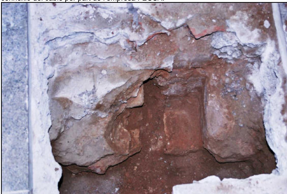
Fotografia 14. Detall des de dalt de les restes del paviment localitzat a la cala A realitzada davant del número,32 de l'Avinguda Portal de l'Àngel. Es pot apreciar com aquest es troba afectat per construccions contemporànies.
