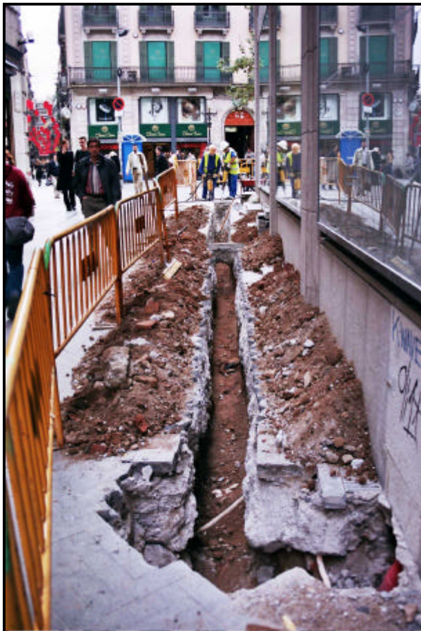
Fotografia 3. Detall llargada total de la rasa 1 realitzada al carrer Comtal, 1.
