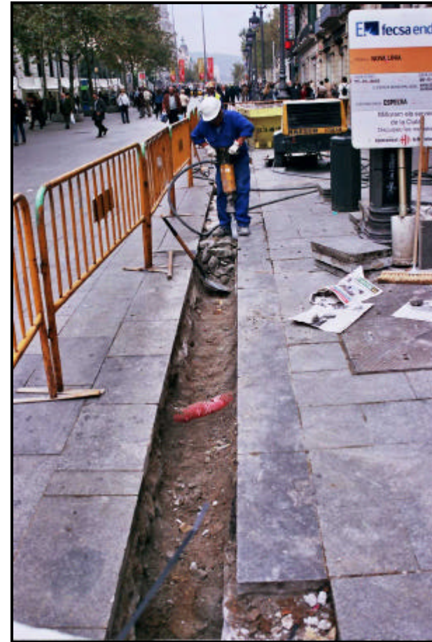
Fotografia 2. Detall tasques obertura rasa 2.
