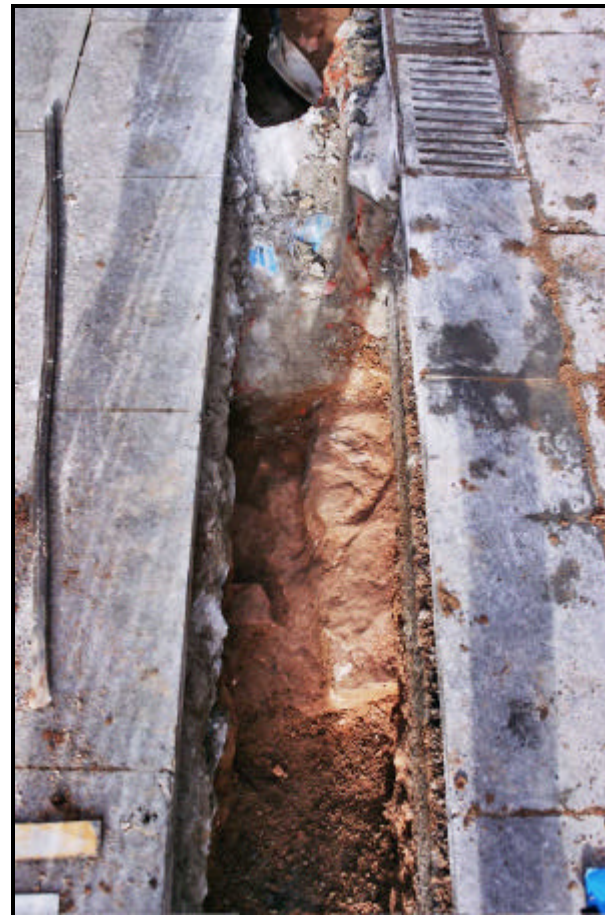
Fotografia 10. Vista sud- nord del mur UE. 203 afectat, com s'aprecia, per la claveguera U.E. 205.
